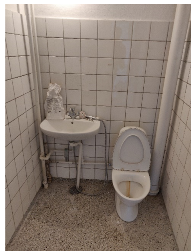
Toilet i afdeling 107
