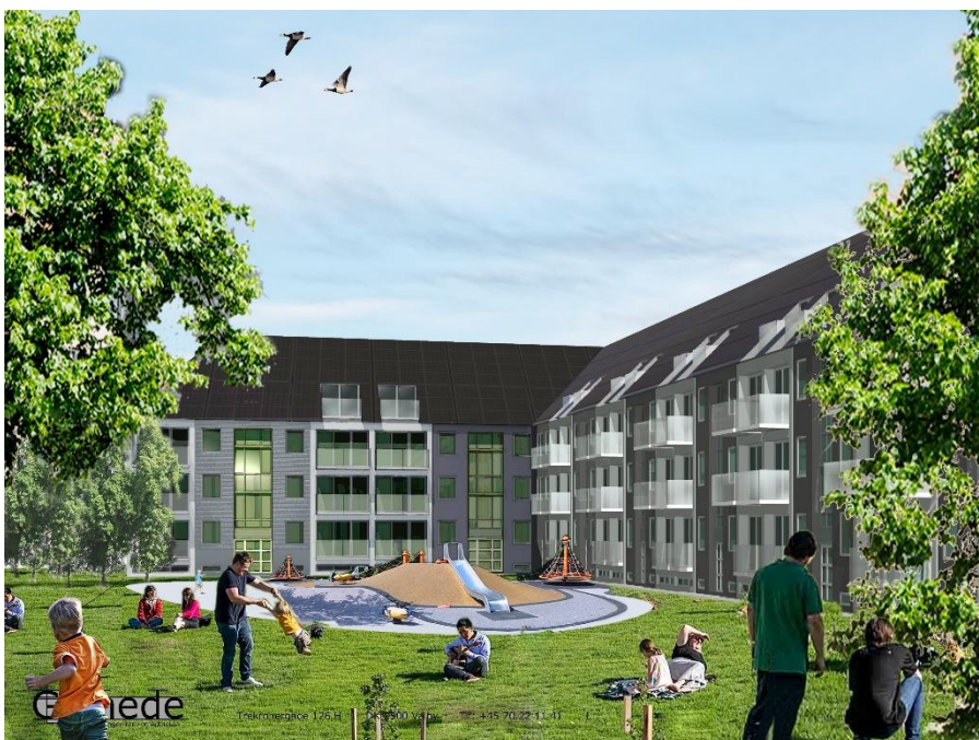
Figur 5. Eksempel på nyt rekreativt område foran bygningen, som er udvendigt efterisoleret afsluttet med pladebeklædning, store nye altaner, store vinduespartier til altaner og glasvægge ved opgangsområde
